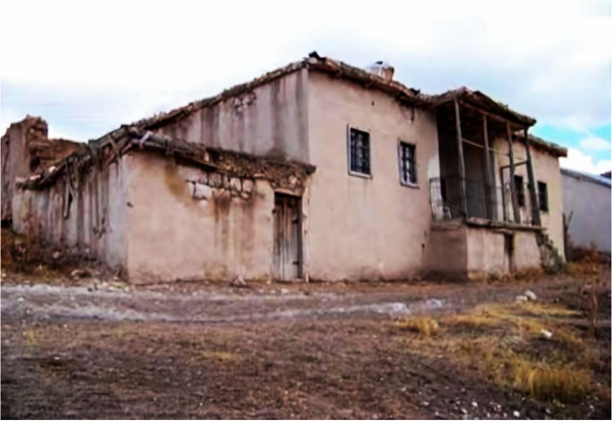
↑ Şekil 1: Gebelek'te kerpiç sıva ve ahşap konut (Çorapçıoğlu vd. 2008)
