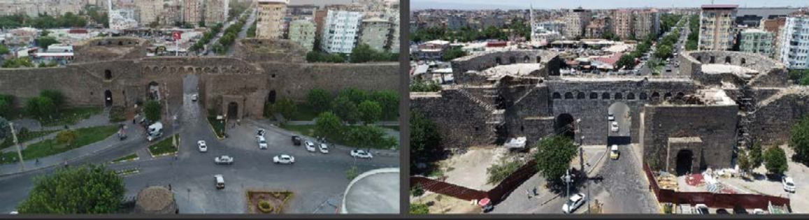
Foto:8- Diyarbakir Surlarının 21 ve 22 No'lu Burçlar
