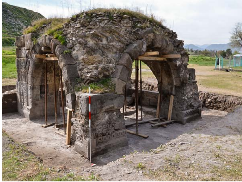
Fotoğraf 4: 2014 Sondaj çalışması sonrası Dört Kemerli Yapı
